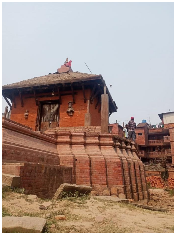
फोटो नं. ९ : तुलाछेँ टोलको जगन्नाग मन्दिरको पुनःनिर्माण ।
