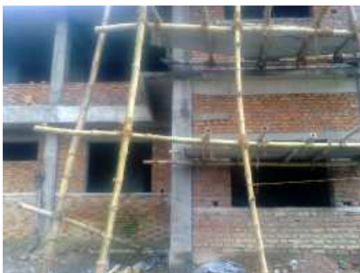
आधुनिक घरको निर्माण कार्य
