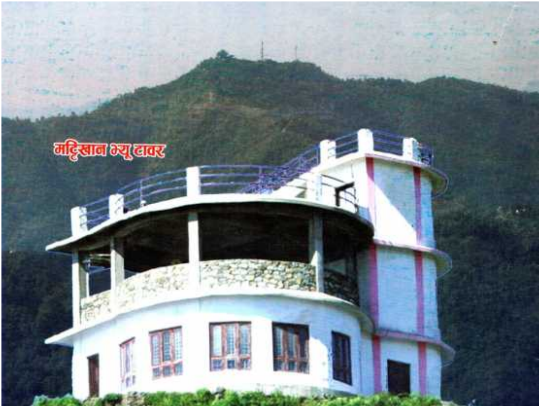
मट्टिखानभ्यू टावरको भवन
