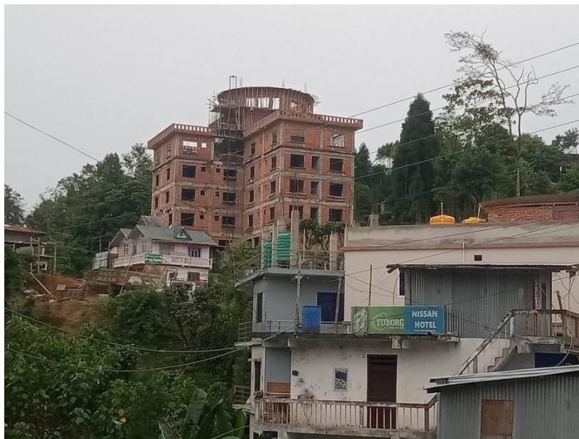
चित्र नं १३ - यही क्षेत्रमा निर्माण भई रहेको आधुनिक घर ।
