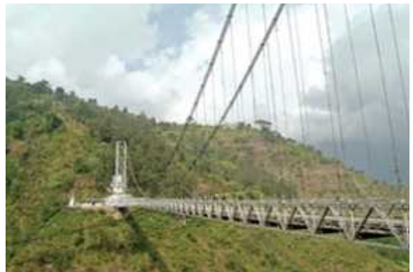
VI. Singshore Bridge
